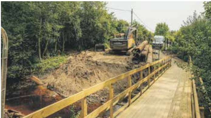
Tilta pārbūve, Piektā iela, VEF-Bīķernieki
