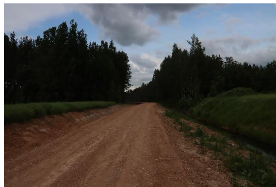
10.attēls. Izbūvēts ceļš un grāvji purva dienvidrietumu malā. 19.06.2020. I.Kukāre
